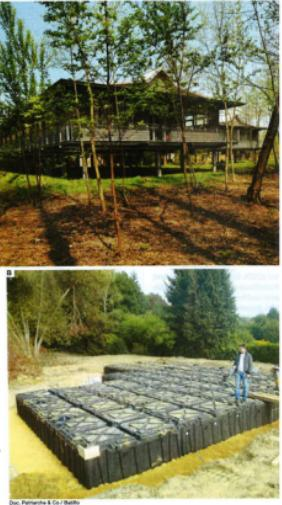
Pour rendre le bâtiment amphibie, il faut concevoir à coups de pilotis tout ce qu'il faut pour assurer la sécurité et la durabilité de l'île. Ici, les fondations sont réalisées avec des blocs de polystyrène recyclable puis empêtrés dans une peau de protection en béton fondurier.
