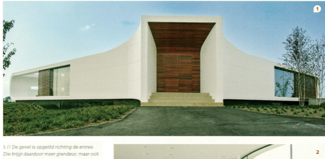
1 // De gevel is opgetild richting de entree. Die krijgt daardoor meer grandeur, maar ook konden zo de pijpjes op het dak aan het oog worden onttrokken. 2 // De glaspui is vrijwel naadloos geïntegreerd in de dakrand en de vloerand. 3 // De buitenruimte is in de schil van Corian geïntegreerd. De rand van Corian is doorgezet rondom het open dak.
