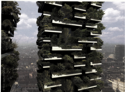
Bosco Verticale in Mailand: Die Begrünung von Gebäudefassaden dient dem Ausdruck der Umweltverantwortung der Bauherren, der Verbesserung des CO 2 -Verhältnisses und bietet damit Vögeln und Kleinstlebewesen einen Lebensraum.
