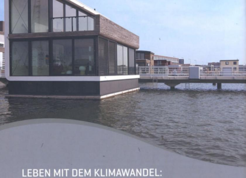
Wasservilla in Amsterdam-IJburg. Sie schwimmt bei steigendem Wasserpegel mit.
